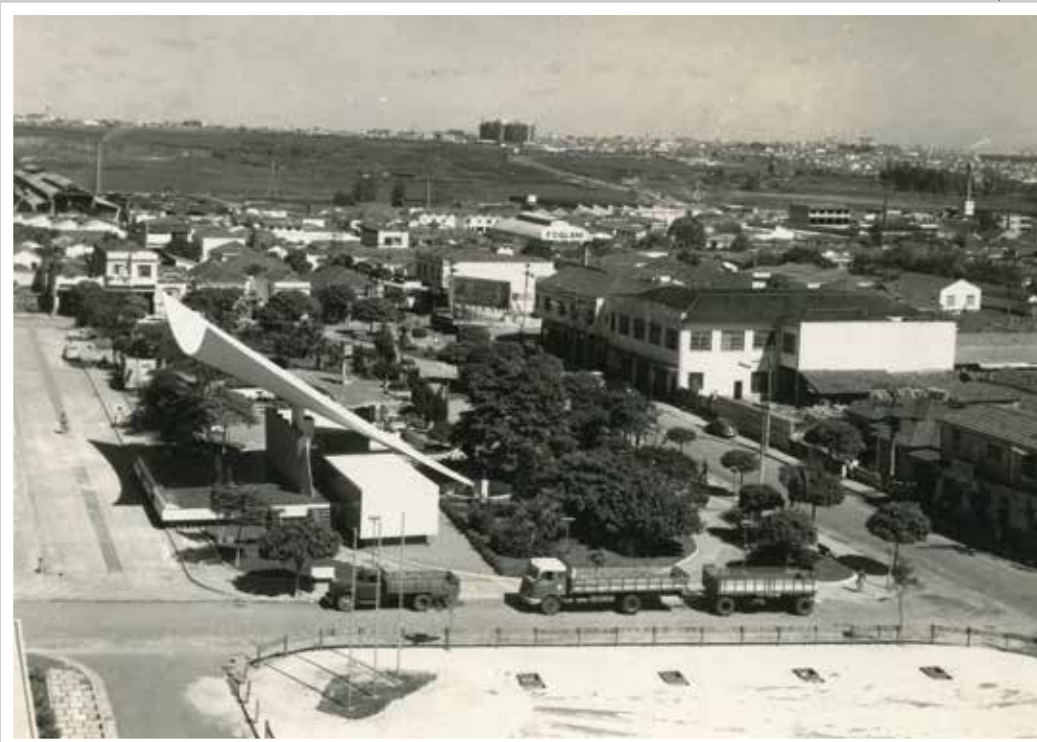
Vista panorâmica da Praça 1º de Maio onde ficava instalada a Concha Acústica. Ainda em construção, vemos a Praça dos Estudantes. Diante da Concha, a Avenida Goiás e, em primeiro plano, a Rua Rio Grande do Sul. Foto da década de 1960
