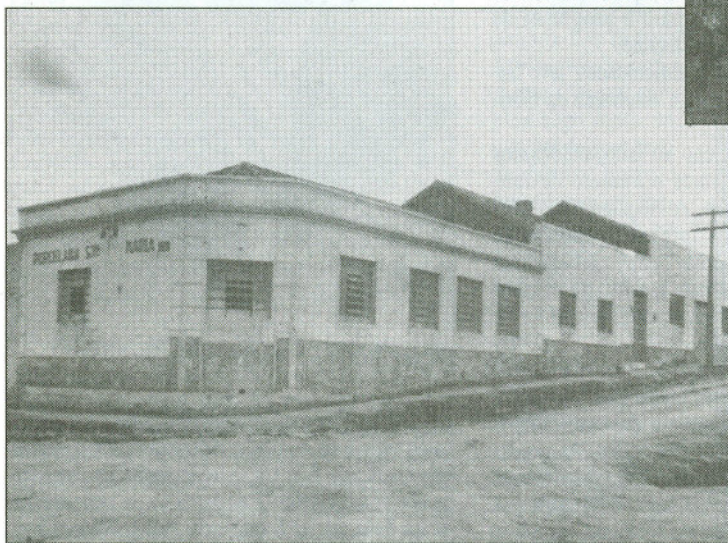
Fábrica de Porcelana Santa Maria já ampliada (1951)
