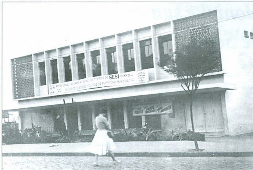
Instalações do Grêmio 28 de Julho, na avenida Goiás, em 1958, hoje ocupados pelo Auditório Santos Dumont e a Academia de Letras do Grande ABC
