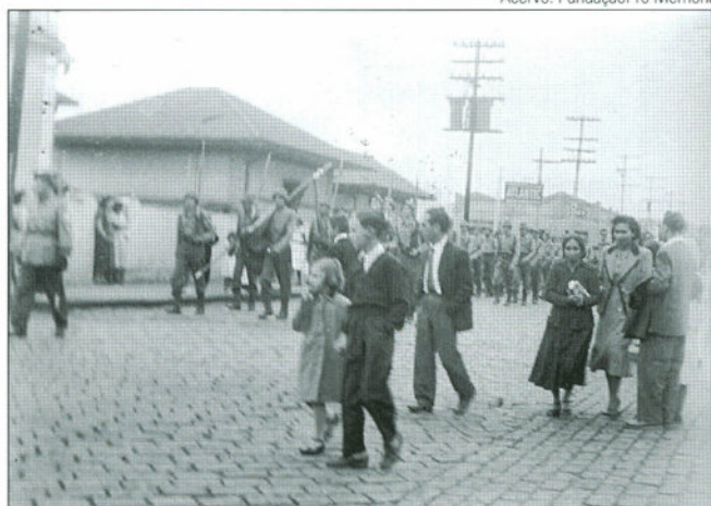
Rua Baraldi, entre a rua Santa Catarina e rua Manoel Coelho
