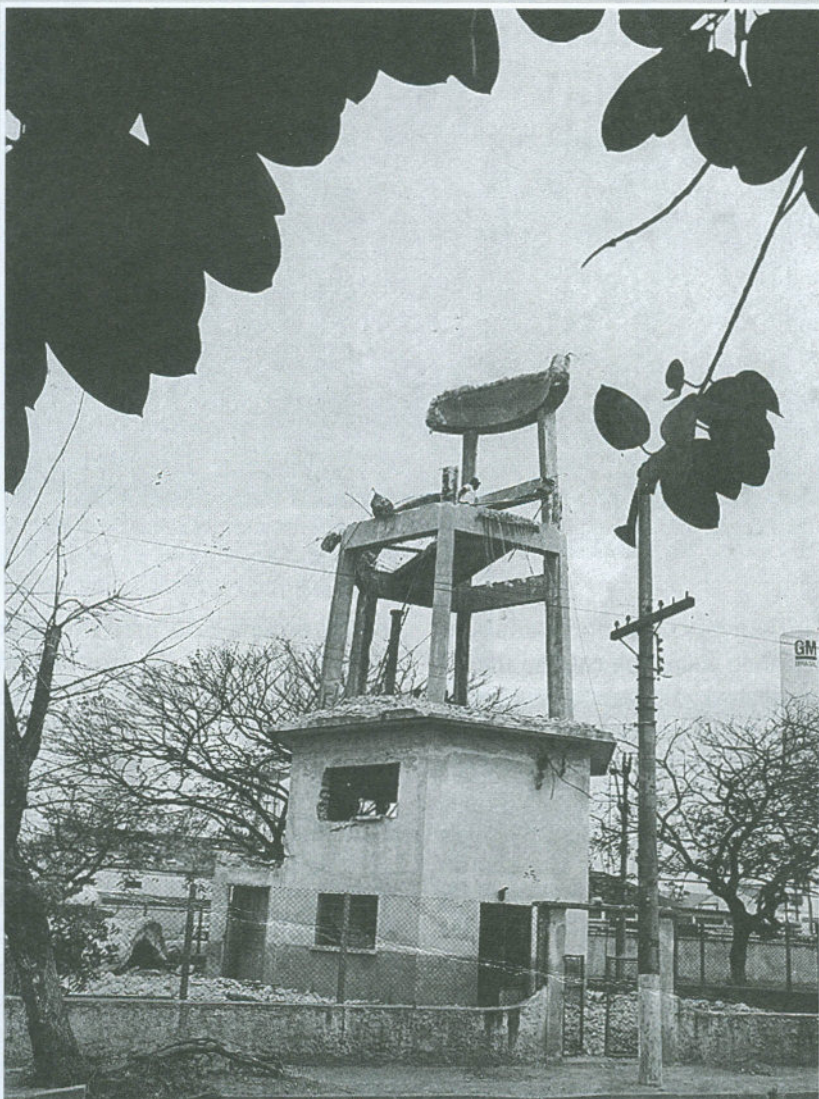
Um dos últimos resquícios da presença de Santo André na Vila Prosperidade. A torre da caixa d'água durante sua demolição
