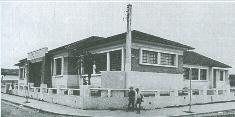
Grupo Escolar Professor Wandelely Ramos Brandão, em Vila Prosperidade, inaugurado em 15 de março de 1952. Hoje neste local, esquina da rua Berilos com rua dos Mármore, existem a EMEI Romeu Fiorelli e EMI Gastão Vidigal Neto
