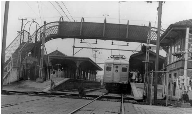
A estação ferroviária de São Caetano do Sul, da São Paulo Railway foi inaugurada em 1º de Maio de 1883. Nesta foto, de 1968, observam-se ainda aspectos arquitetônicos originais, como as colunas de sustentação e o pontilhão de passagem para pedestres
