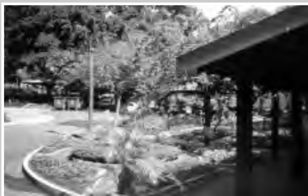
Vista atual da fachada da Escola de Ecologia
