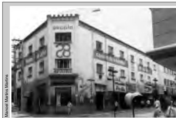
Edifício onde funciona a Escola de Desenho 28 de Julho, no cruzamento das ruas Santa Catarina e João Pessoa
