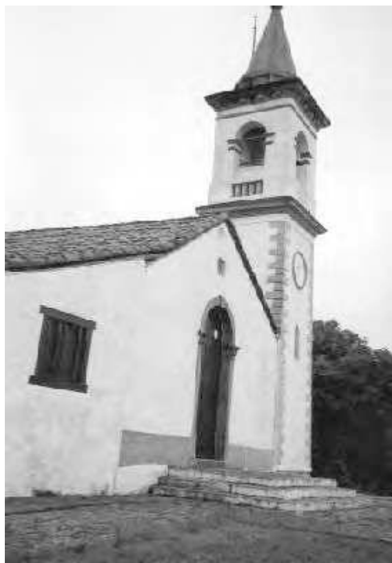
Outubro de 2005 - Capela de N.S. do Pilar, Ribeirão Pires. Estado atual, após reformas
