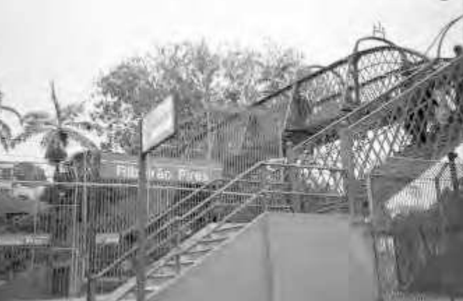
Outubro de 2005 - Detalhe da antiga escadaria sobre os trilhos da ferrovia SPR (hoje Santos a Jundiá), na Estação de Ribeirão Pires
