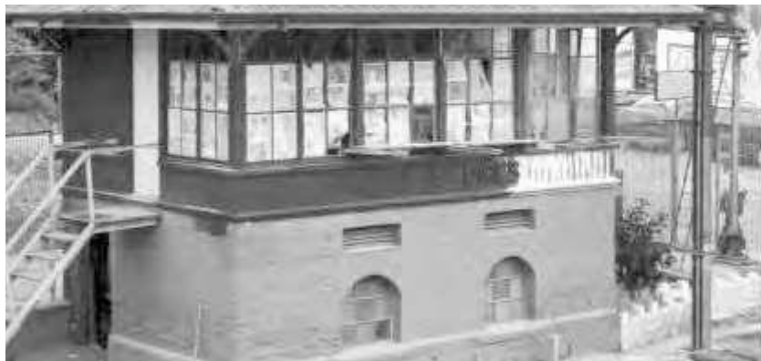
Outubro de 2005 - Casa de Controle da Ferrovia S.P.R. na Estação de Ribeirão Pires. O prédio é de maio de 1885
