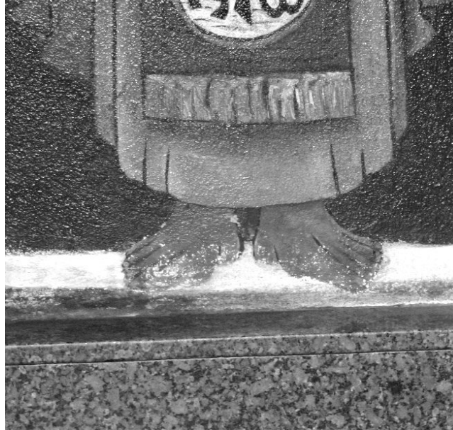
Pintura escurecida e com manchas esbranquiçadas
