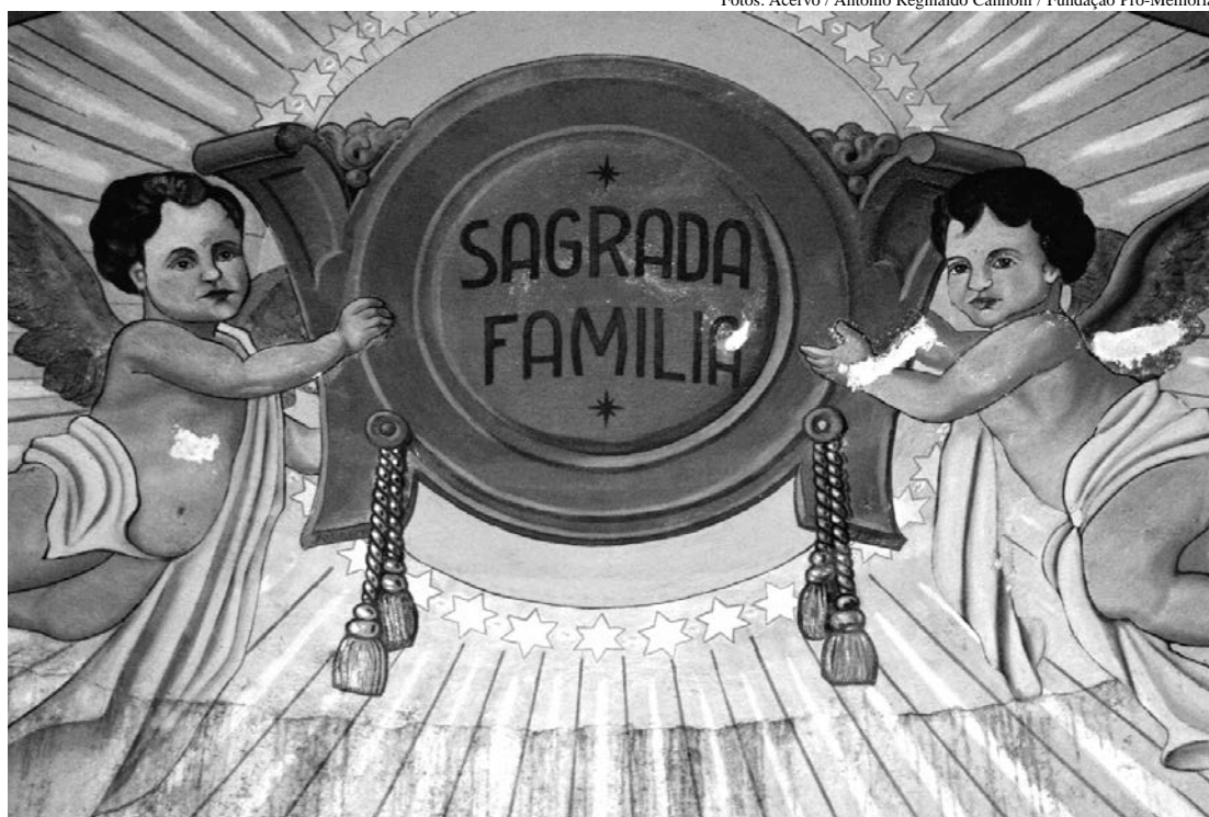
Capela da Sagrada Família dá sinais evidentes da infiltração de água
