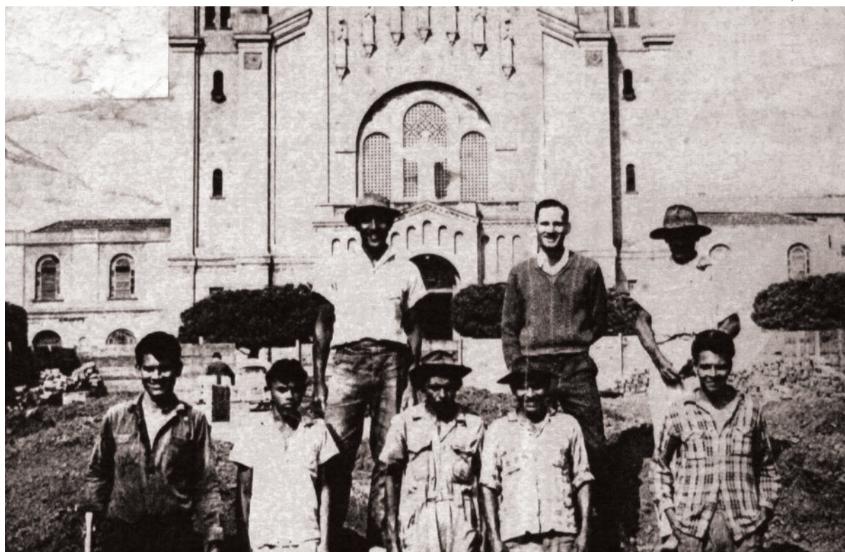
Primeira reforma da Praça Cardeal Arcoverde, em 1963, quando foi instalada a fonte luminosa sonora. Junto com os operários da obra, o vereador Fábio Ventura (na parte de cima, entre dois operários)
