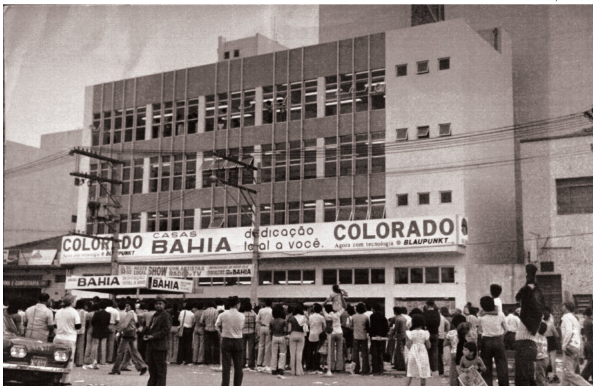
Inauguração do magazine "Casas Bahia", em São Caetano do Sul, na Rua Serafim Constantino, em frente à Estação Rodoviária. Ano: 1976
