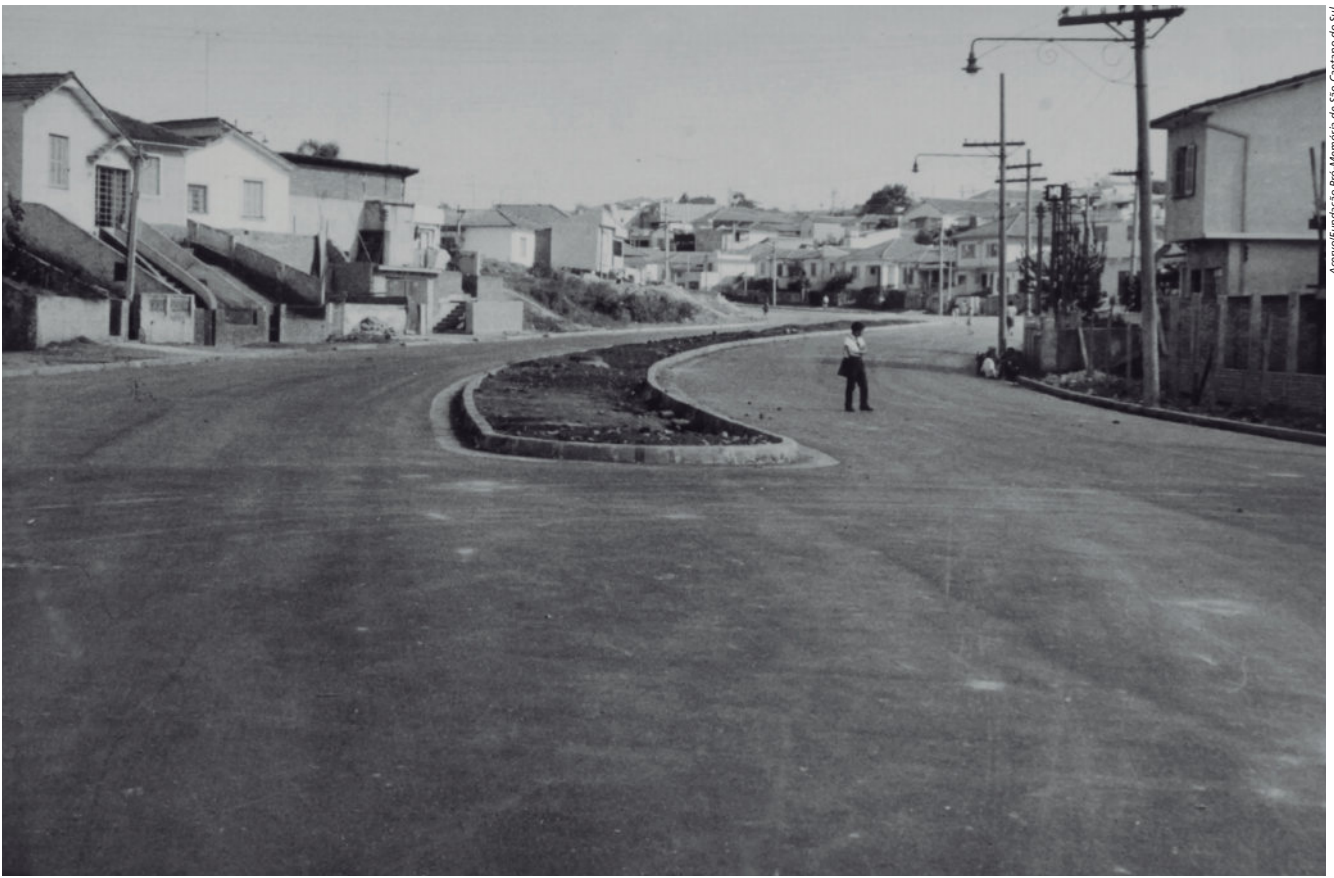
Avenida Tijucussu sendo asfaltada. O trecho fica entre as ruas Ingã e Itápolis. Hoje é uma moderna via, arborizada e com ciclovia. Foto da década de 1960
