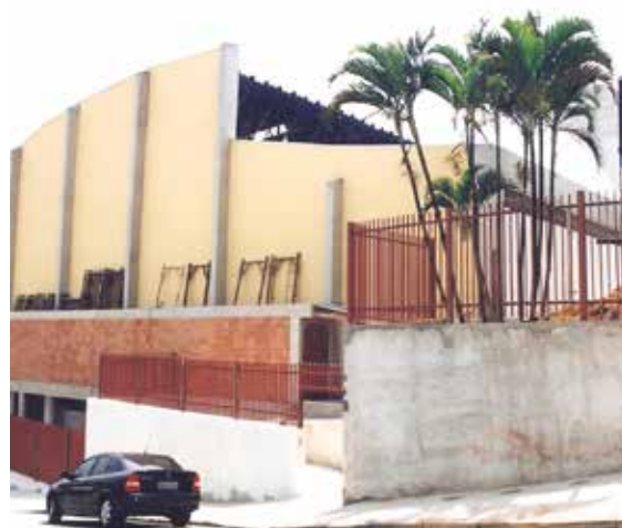
Construção da quadra do Centro Poliesportivo Delenice Aparecida Fonseca Oliveira, utilizada atualmente para treinamento da equipe masculina de basquete de base e de alto rendimento. Foto de 2003
