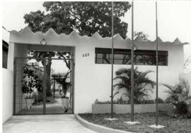
Fachada do Centro de Integração Educacional Comunitário Benedicto Djalma Castro no ano de sua fundação, em 1992. O Clubinho da Prosperidade possui infraestrutura de lazer aberta à comunidade
