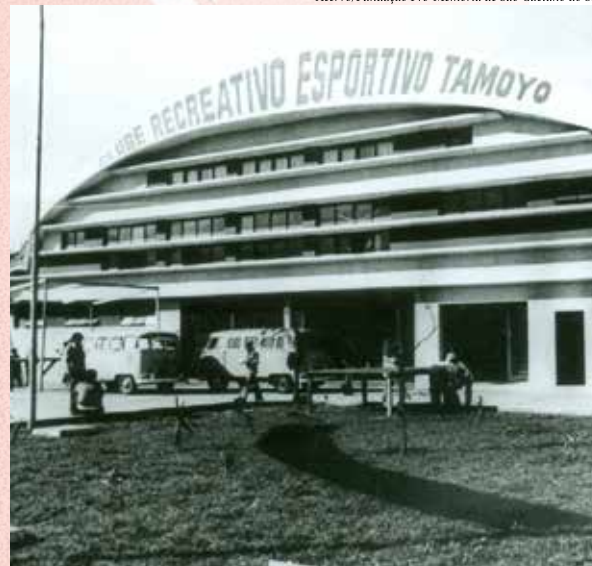
Sede do Centro Esportivo e Recreativo Pedro Furlan – Tamoyo, estruturado com ginásio de esportes, campo de futebol, piscina e salas para aulas de ginástica. Foto de 1995
