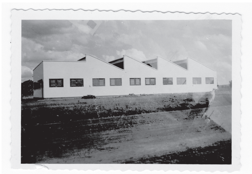
Prédio da Cerâmica Artística Di Thiene, sediada em Santa Cruz das Palmeiras, interior de São Paulo. Foto de maio 1955 Acervo/Urames Pires dos Santos
