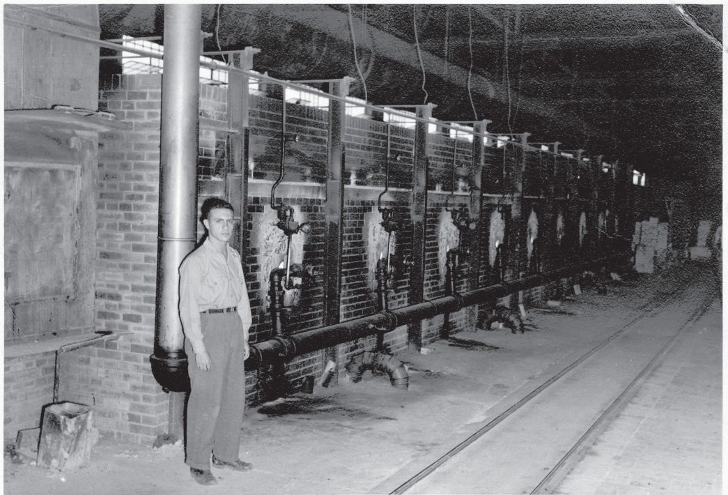
Urames na zona de queima do primeiro forno túnel da Cerâmica São Caetano, em 1953
