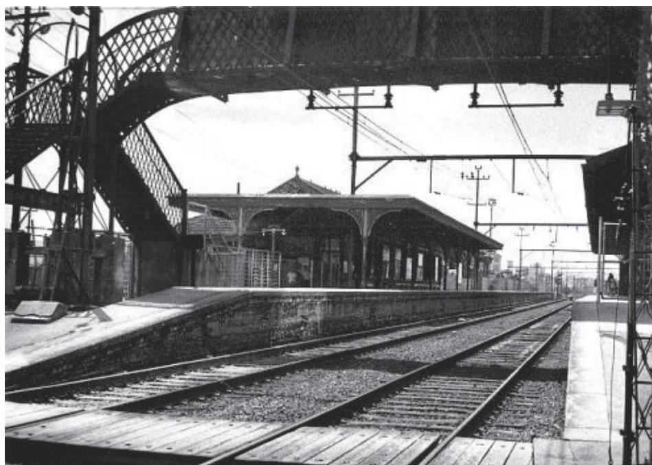
Plataforma da Estação de São Caetano, na São Paulo Railway, construída e aberta ao uso em 1883 (Foto: 1956; Coleção do Arquivo Histórico da RFFSA; pesquisa de Marco Zambello).
