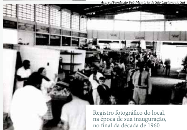
Acervo/Fundação Pró-Memória de São Caetano do Sul Interior do mercado, com destaque para a estrutura de alvenaria e azulejos dos boxes
