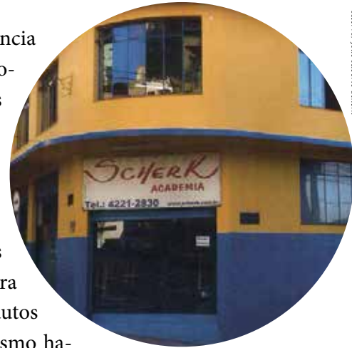
Fachada do edifício da Scherk Academia, de propriedade de João Alberto Scherk (neto de José Scherk), fundada em 1975. Está localizada na esquina das ruas Piauí e Wenceslau Brás. Foto de 2015
