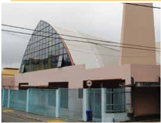
Fachada atual da Igreja Nossa Senhora das Graças. Foto de 2020
