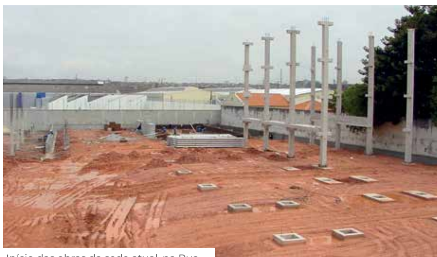
Início das obras da sede atual, na Rua Major Carlo Del Prete. Foto de 2003
