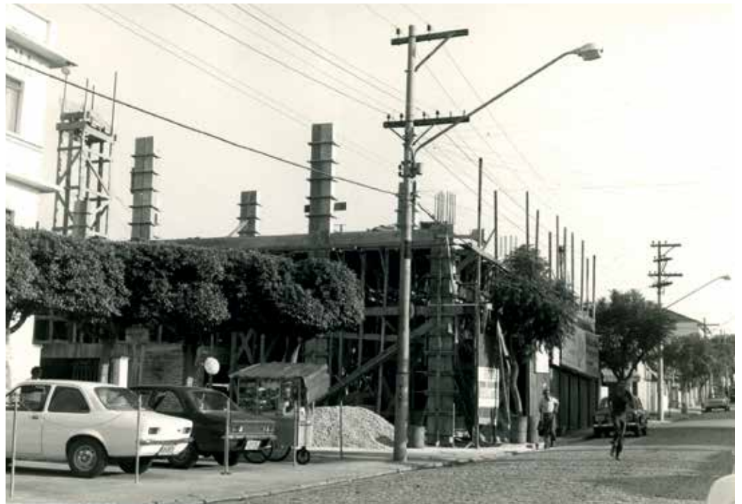
Construção da segunda ala do Hospital Nossa Senhora de Fátima, situada na esquina das ruas Nossa Senhora de Fátima e Gonzaga
