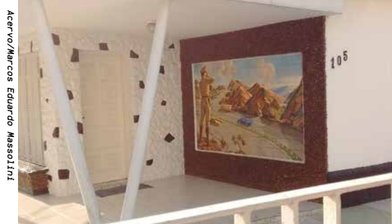
↑ Detalhe da lateral da varanda da casa, com destaque para o icônico painel artístico em azulejo
