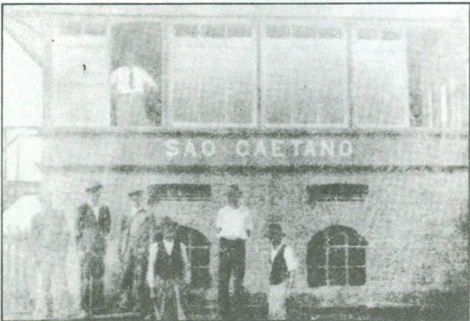
Cabine sinaleira da Estação da São Paulo Railway, vendo-se na parte superior o sr. Avelino Poli, chefe da estação. Embaixo, diversos funcionários da SPR (anos 30)
