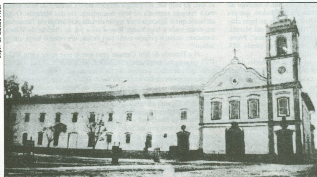
Igreja e Mosteiro de São Bento, em 1870. Na obra do século 18, telhas, tijolos e pirâmides de adorno da torre fabricados em São Caetano
