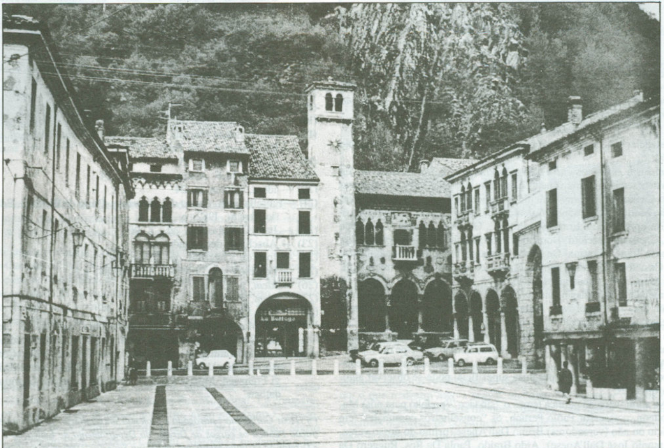
A Praça Marc’Antonio Flaminio, coração de Serravalle. Ao fundo, à direita, sobressai o Palazzo della Comunità Serravallese, que, em tempos idos, abrigou o Conselho dos Nobres. A torre romana ostenta sinos e um relógio. Construído entre 1462 e 1476, abriga hoje o Museo Cenedense.
