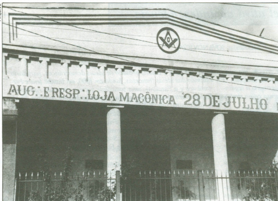
Loja Maçônica 28 de Julho, situada à Avenida Kennedy
