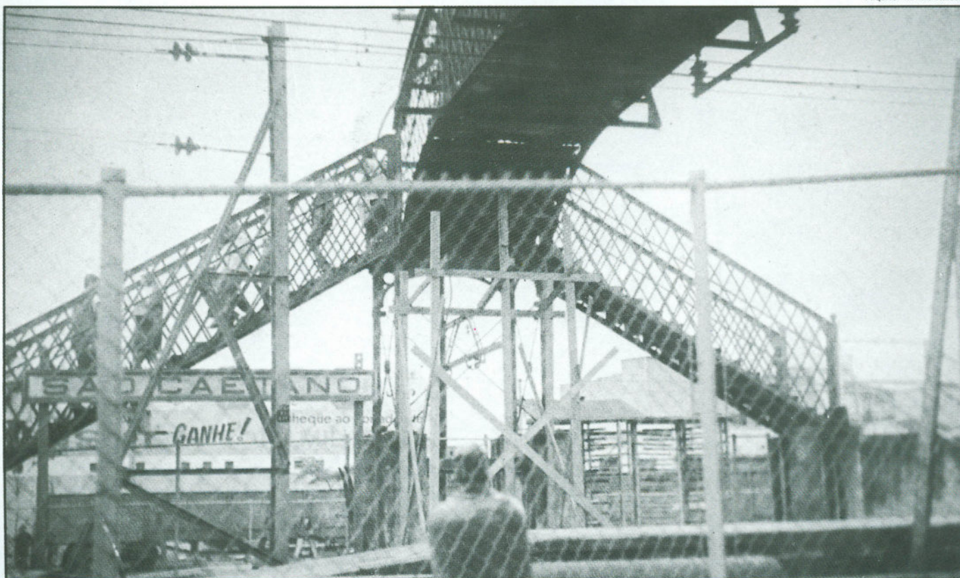
Ponte de ferro para travessia de pedestre sobre o leito da Estrada de Ferro São Paulo Railways (posteriormente Estrada de Ferro Santos—a—Jundiaí), na estação de São Caetano. Fotos sem data, anteriores à demolição e à construção da nova estação.
