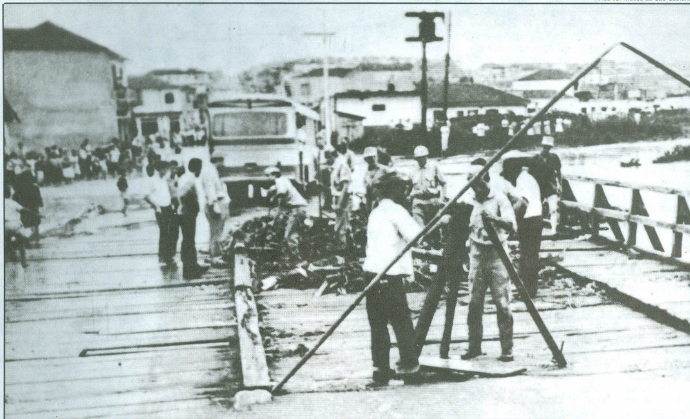
Depois das cheias, o trabalho de limpeza e reparo dos estragos. Foto sem data, tirada da ponte da Vila Califórnia (Coleção do Jornal de São Caetano)
