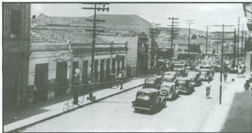
No canto esquerdo, o sobrado em que funcionava a “loja da dona Etelvina” (à janela, Etelvina e a nora, Ermelinda). Ao lado, o bar Ao Nosso Rancho, de Dante Massei e a bomba de gasolina. Ao fundo, as portadeiras da estrada de ferro e o bar Trianon. Circa 1950.
