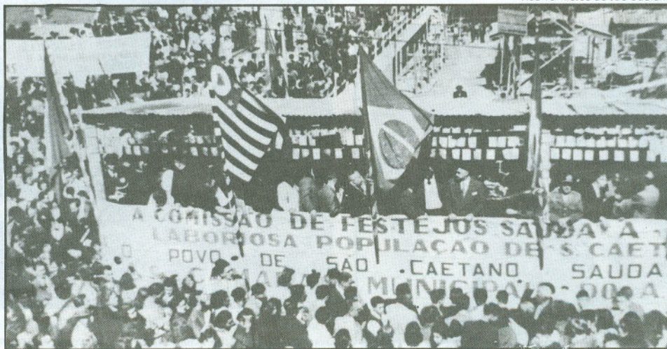
Flagrante da inauguração do Viaduto dos Autonomistas, em 28 de julho de 1954
