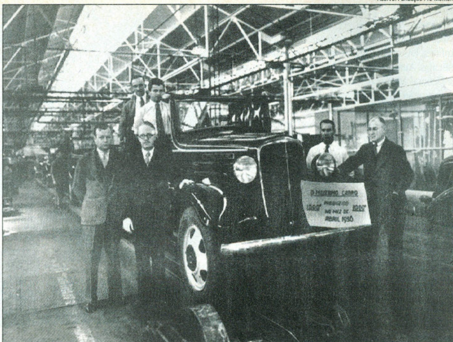
“Abril de 1936 - Sai da linha de montagem da General Motors de São Caetano o milésimo veículo produzido. O Caminhão Chevrolet Gigante”.
