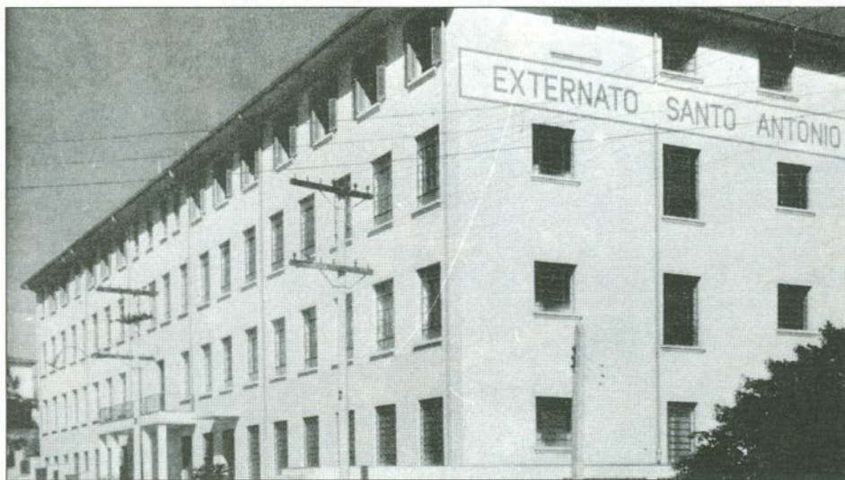
Prédio atual do Externato Santo Antonio. “Estas paredes nada significaram se não houvesse você, presença humana”.
