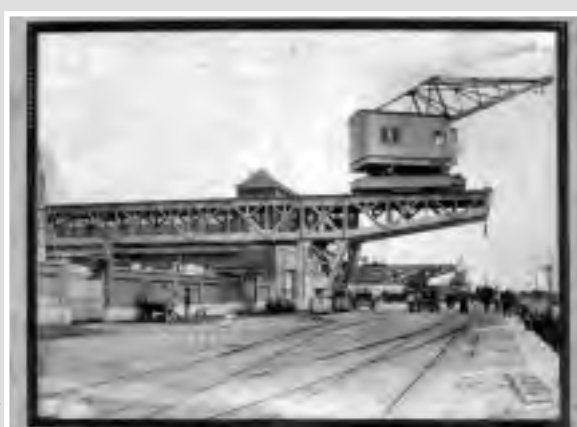
Ponte com guindaste móvel da S. M. Construções Elétricas
