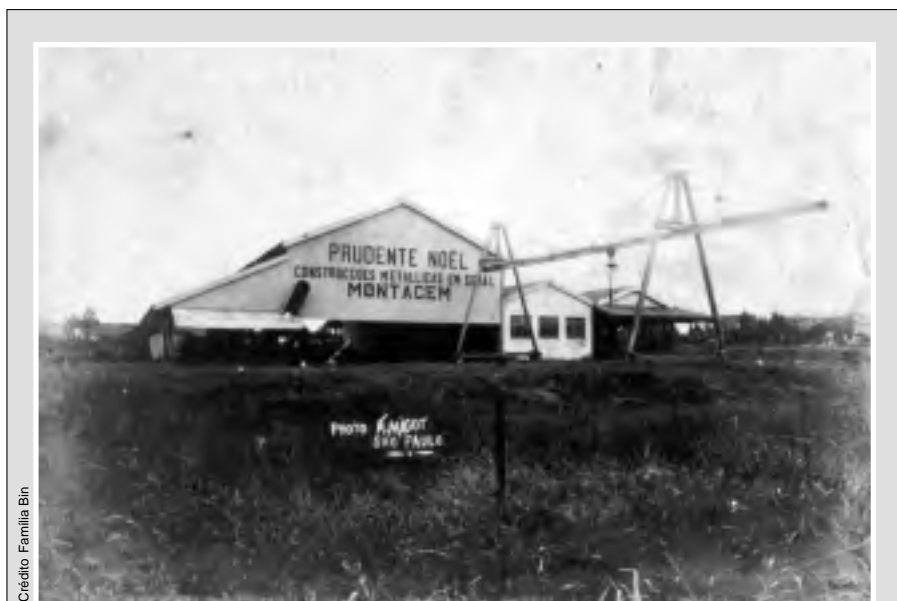
Fábrica de Prudent Noël em São Caetano, na Rua 28 de Julho
