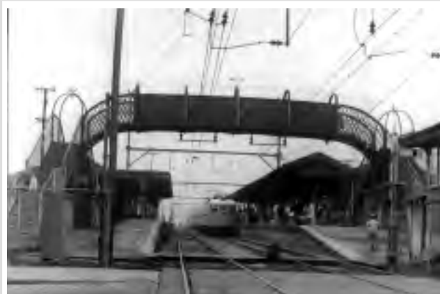
Vista da plataforma e da antiga Estação de São Caetano do Sul
