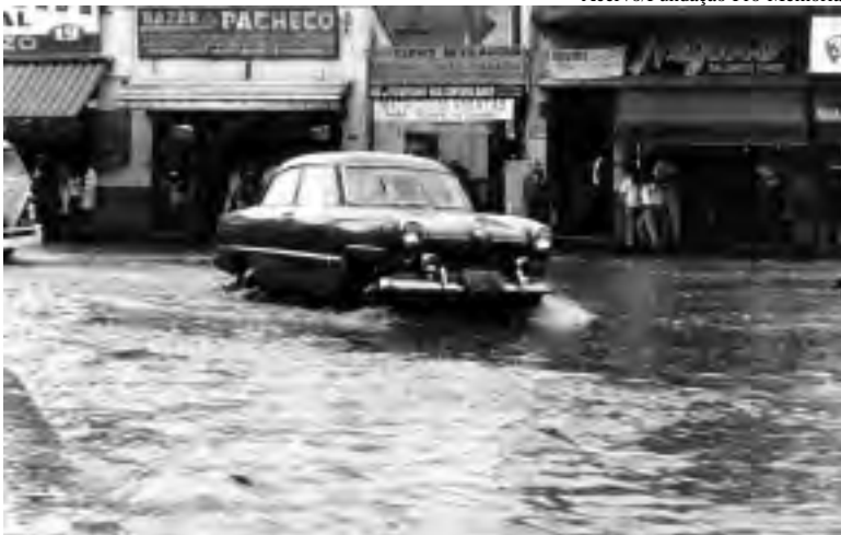
Rua João Pessoa, no centro de São Caetano, durante inundação na década de 1960
