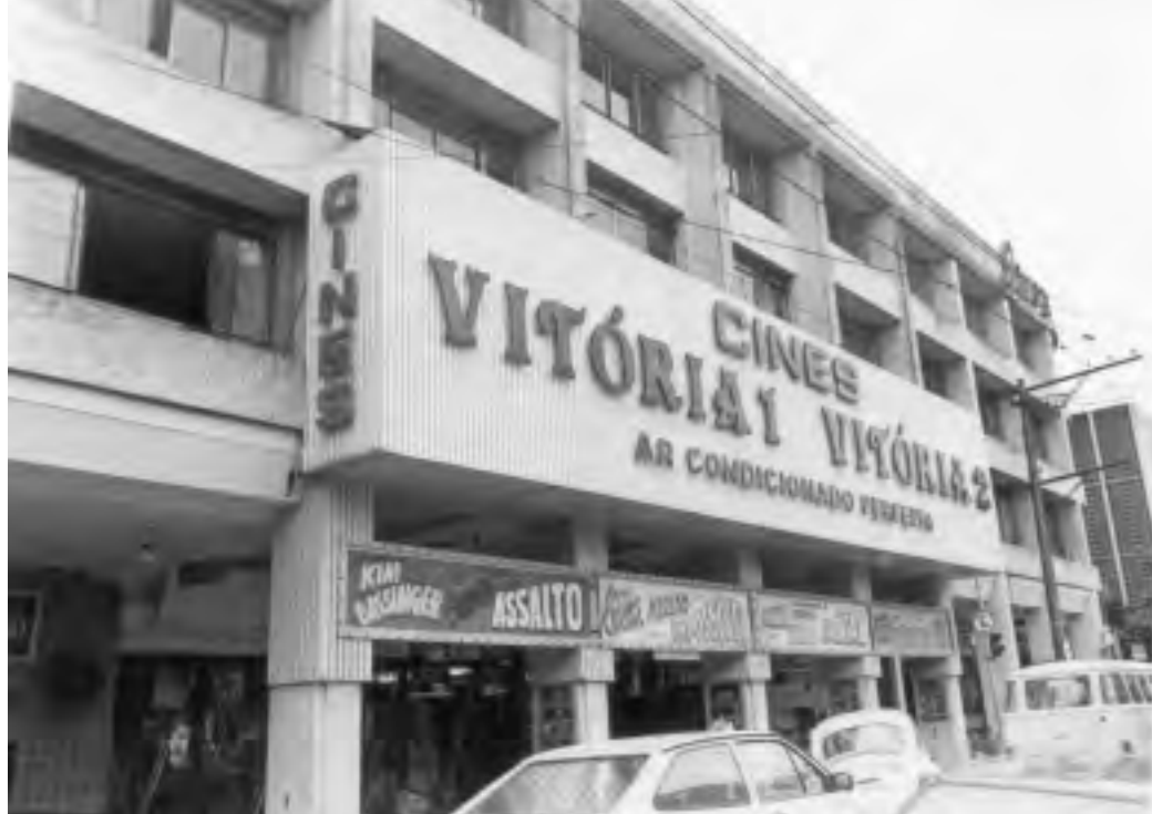
Detalhe da fachada do Cine Vitória, no início da década de 1990
