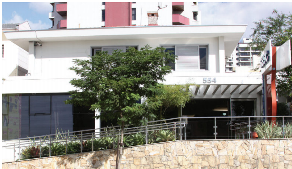
Fachada externa do SESC São Caetano, na Rua Piauí, bairro Santa Paula. Ano 2010
