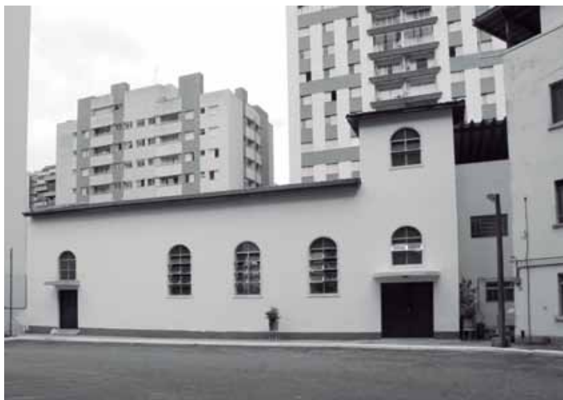
Fachada da capela do Hospital São Caetano. A pedra fundamental da capela foi lançada em oito de janeiro de 1955
