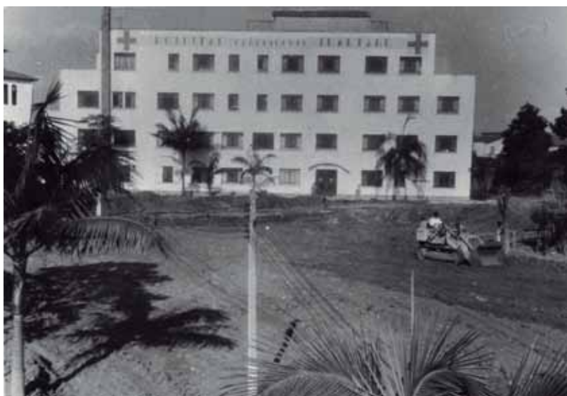
Fachada do primeiro bloco do Hospital São Caetano, em fase final de acabamento. Foto de 1954
