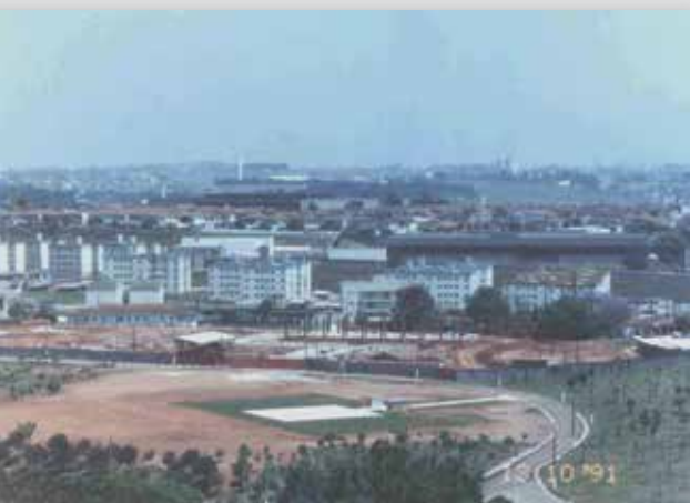
Visão inicial das obras do Palácio da Cerâmica, em outubro de 1991
