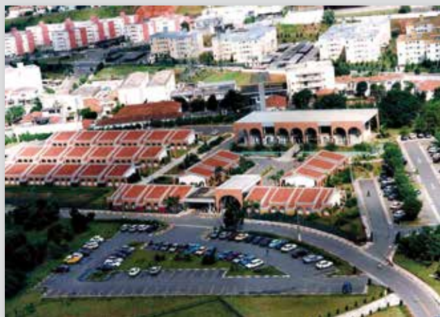
Vista aérea do complexo administrativo nos anos 1990
