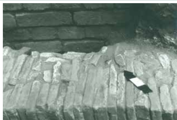
Detalhe da estrutura de lajotas (contrapiso da Capela de São Caetano) – setor 11. Foto de 1992
