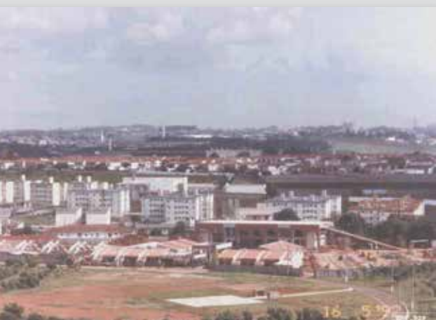
Em maio de 1992, as obras do novo Paço já estavam em estágio avançado
