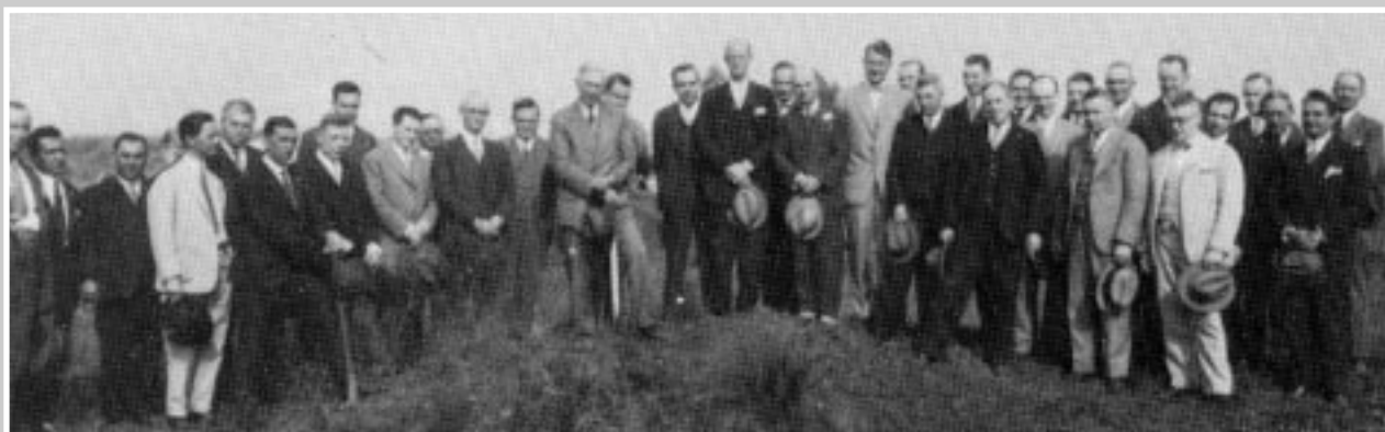
Cerimônia do início da construção das instalações da GM em São Caetano, ocorrida em 24 de Setembro de 1927
