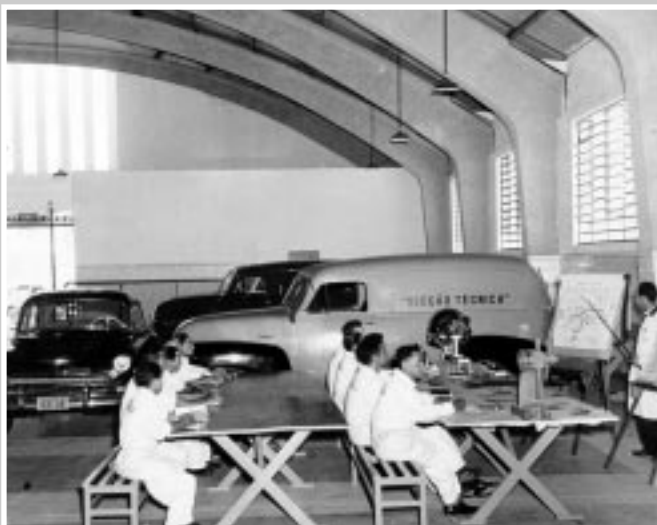
Escola volante instalada em Fortaleza (1953). Nunciato Menitti é o instrutor. As aulas eram improvisadas na garagem onde se vê o furgão da Seção Técnica da General Motors do Brasil
