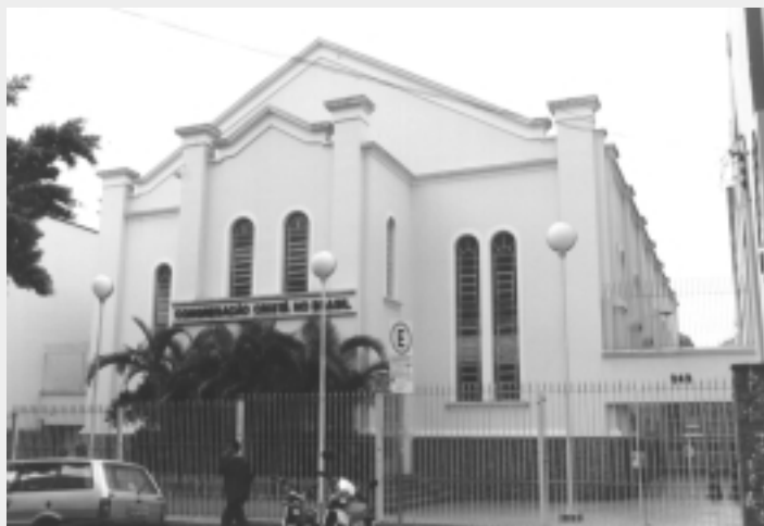
Congregação Cristã no Brasil, depois da reforma
